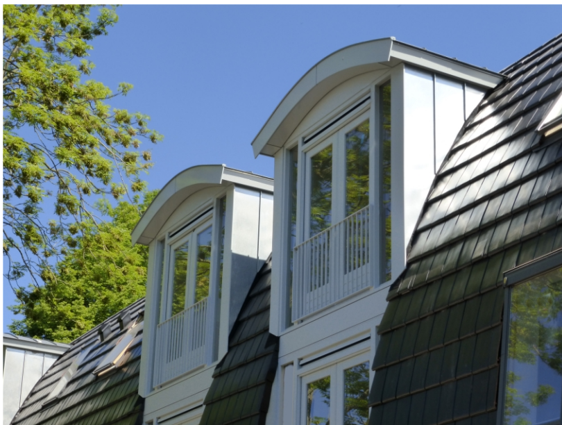
Aansluitray toegepast bij getoogd dak
